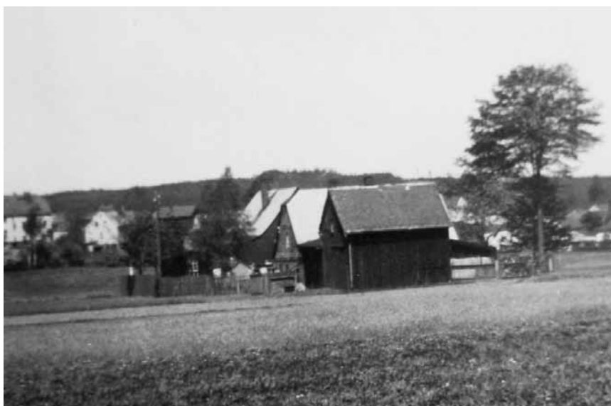
Kleines Bauerngut Nr. 53, wurde in den 1990er Jahren abgerissen
